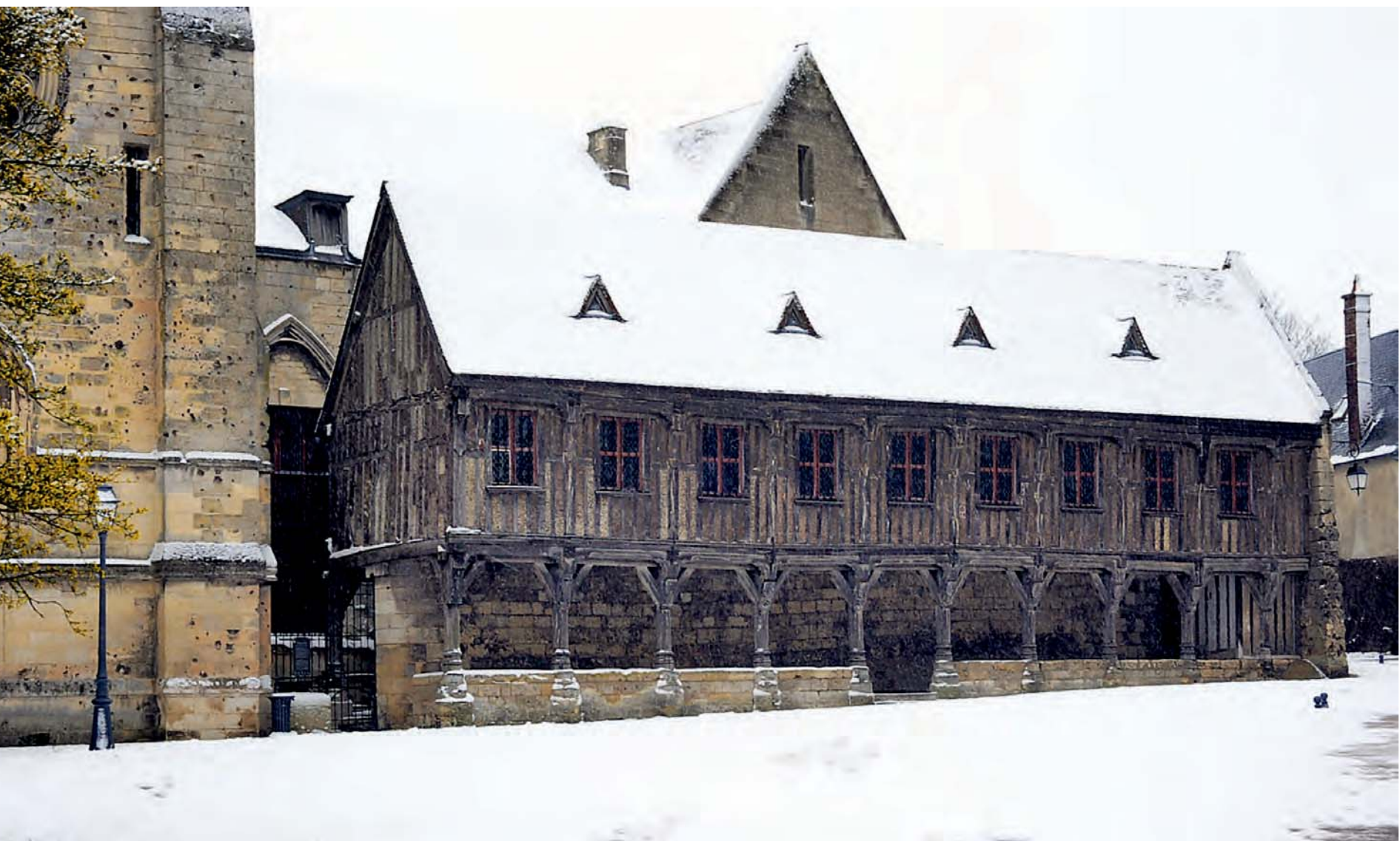
Unique en France, bibliothèque à pans de bois, ou librairie du chapitre, construite en 1506. Jusqu'au XIX e siècle, le rez-de-chaussée était muré et habité.
